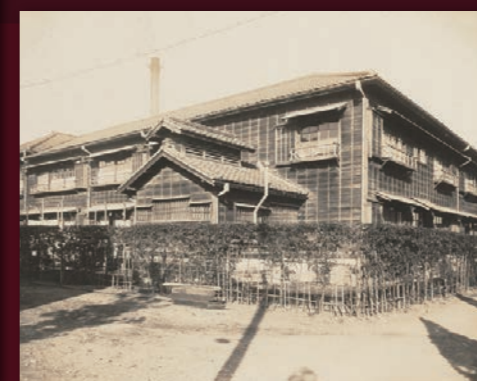
1919年 養成所寄宿舎 四ツ谷信濃町の病院敷地内に養成所並びに寄宿舎を移転
